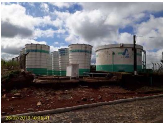
Foto 61 - Conjunto de reservatórios
