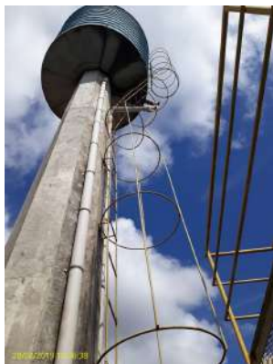
Foto 75 - Escada de acesso
