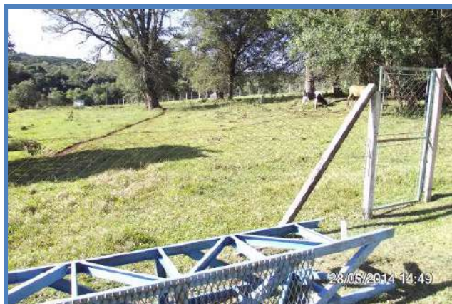
Imagem 12: Cerca tipo alambrado no entorno da ETA.
