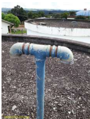
Foto 56 - Duto de ventilação
