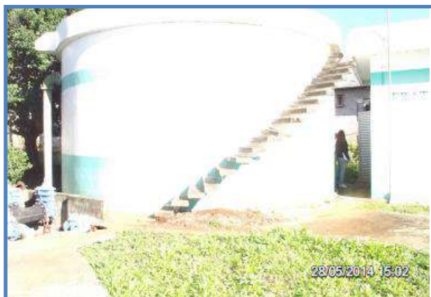
Imagem 22: Escada de acesso à cobertura de um dos Reservatórios R 01.
