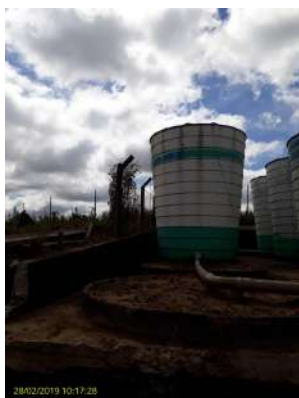
Foto 64 - Não há isolamento da área
