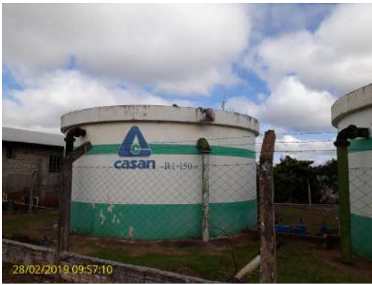
Foto 51 - Reservatório em concreto do tipo apoiado
