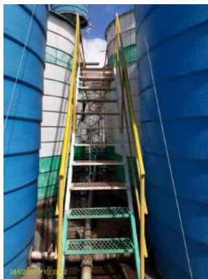
Foto 73 - Escada de acesso
