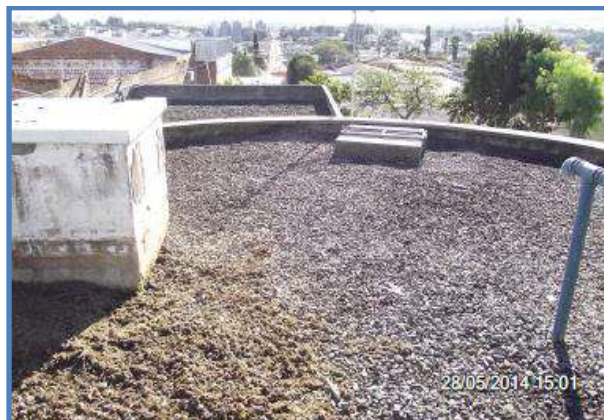
Imagem 25: Cobertura de um dos Reservatórios R 01.
