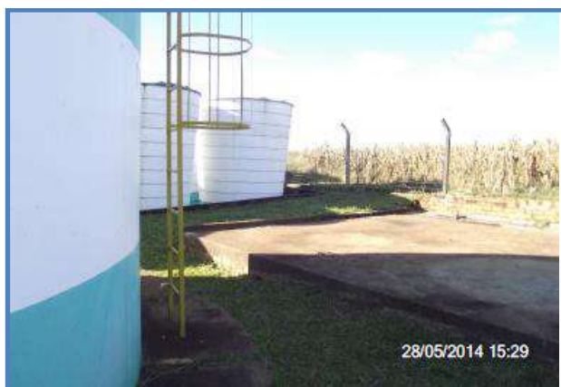
Imagem 28: Escada de acesso à cobertura do Reservatório R 02A.
