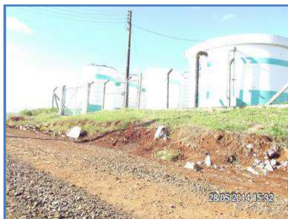
Imagem 7: Reservatório R 02A (à direita da foto) e Reservatórios R 02B (à esquerda da foto).
