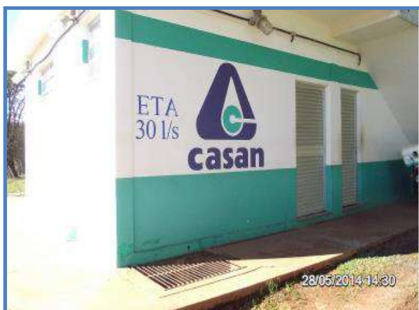
Imagem 3: Estação de Tratamento de Água.
